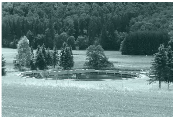
Ansteuerung von Pumpen, Bojen, ...
