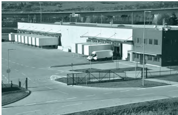
Toransteuerung mit Adressierung...
